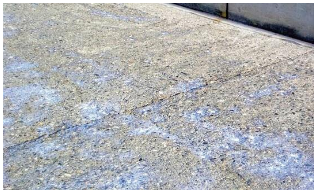
Sottofondo trattato con Ancorlattex
