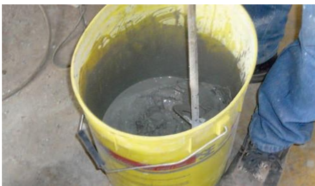
Preparazione di Pavilevel 300F con il mescolatore elettrico
