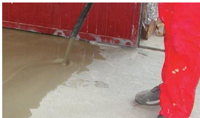
Applicazione di Pavilevel 300F a pompa
