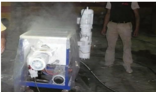
Preparazione di Pavilevel 300F a macchina
