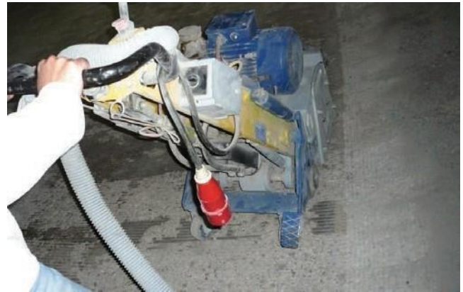
Preparazione del sottofondo mediante la fresatura
