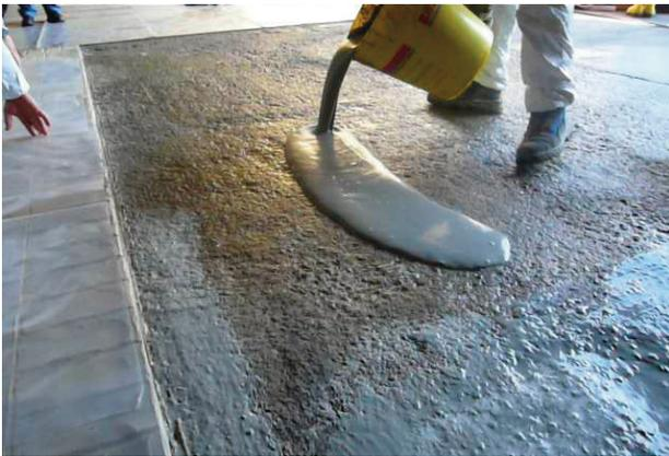
Prima di applicare il betoncino (SFERODUR FP o SFERODUR 2-5) o l'intonaco (DECOQUARZ VERTICAL) verificare che lo strato di collante sia uniformemente bagnato. Parti parzialmente asciutte vanno rinvivate con ulteriore strato di APSECOL BETON.
